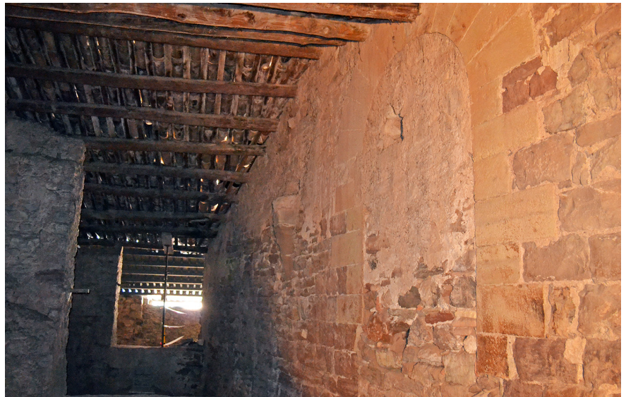
En primer terme, antic portal del Castell, que es recuperarà i s'obrirà de nou L'accés, tapiat des del segle XIX, es troba sota la coberta de la nau nord del temple
