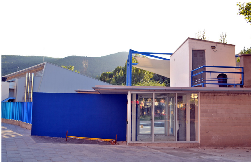
El nou vestíbul i la tanca dels dos equipaments, després de les obres L'accés ha estat construït coincidint amb la temporada d'estiu de les piscines
