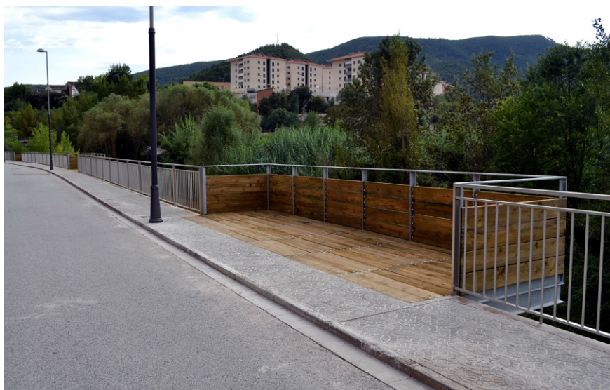
Un dels nous miradors construïts amb l'ampliació de la vorera de Cal Trist
