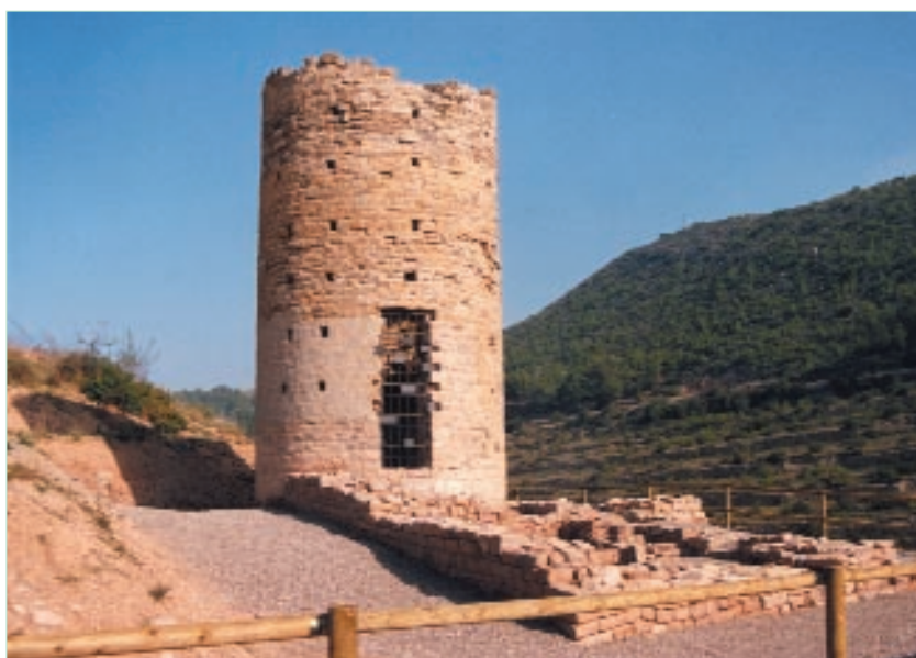
Primera fase de treballs a la Torre de la Pobla, consistent en la seva excavació i consolidació. És previst que en el futur es porti a terme el procés de museització.
