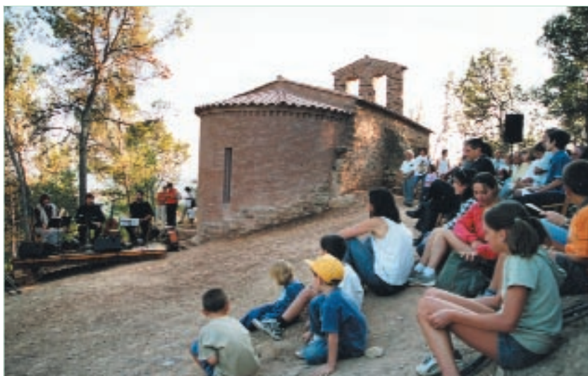
S'ha recuperat l'ermita vella de Sant Salvador del Quer (s. XII), que amenaçava perill d'esfondrament, reconstruint el seu absis romànic, la portalada original i una terrassa d'entrada.
